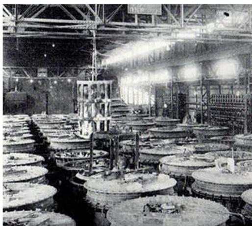
図1. 日本窒素肥料の石灰窒素炉
